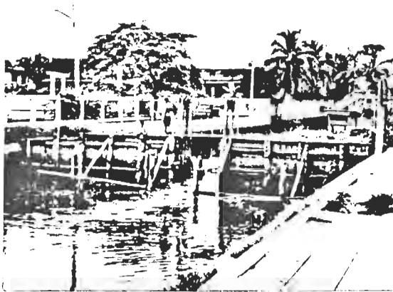
ก) ประตูระบายน้ำชั่วคราว อยู่ในคลองเบรม-ประชากร
