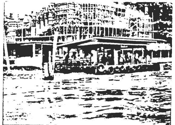
ง) ป้ายชื่อท่าเรือหันไปในแนวเดียวกันกับความยาวทางน้ำ ทำให้ยากแก่การมองเห็นเมื่ออยู่ในเรือ และป้ายมีขนาดเล็กเกินไป ไม่แสดงความสัมพันธ์กับสายรถประจำทาง (ท่าเรือพรานนก)
