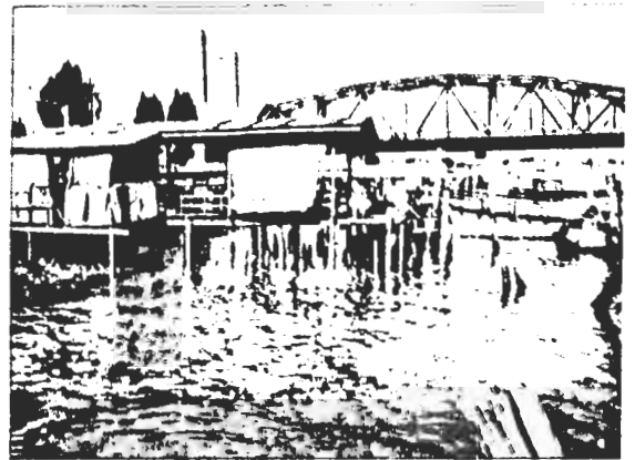
ง) ที่พิกัดโดยสารทำด้วยโครงสร้างไม้อาจถล่มน้ำกัดเซาะให้ยุบกร่อน ซึ่งเป็นอันตรายได้ และสภาพอาคารที่สร้างแบบกิ่งชั่วคราวเป็นสภาพที่ขาดสุนทรียภาพ (ท่าเรือควนสะพานพุทธ)
